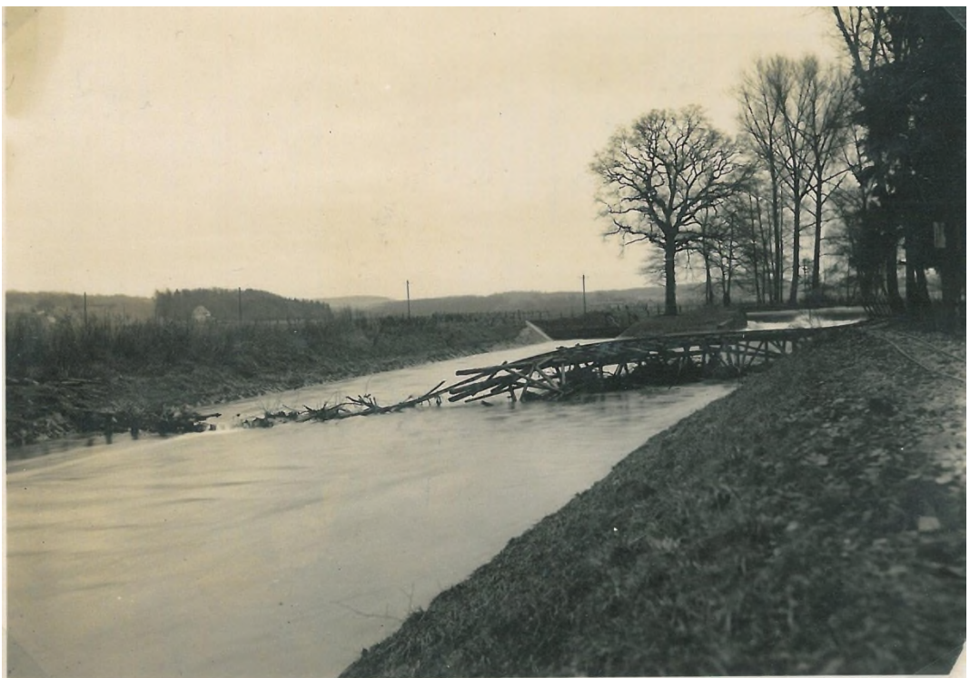
Abb. 12: Mit welcher Baumaßnahme die Feldbahnbrücke in Verbindung stand, ist nicht bekannt. Im Hintergrund ist das Freudentaler Wehr und der Hochwasserumgehungsgraben (links) zu erkennen. 06.01.1932
