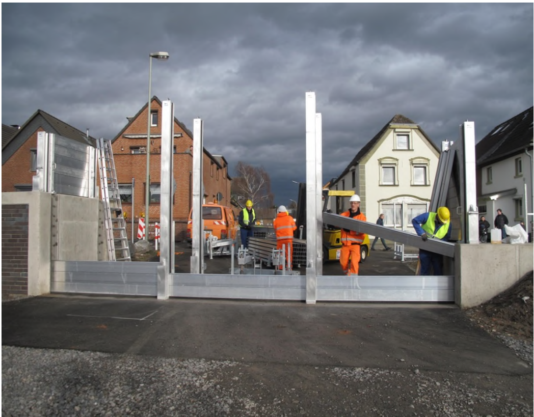
Abb. 77: Aufbau des Hochwasserschutztors „Werftstr.“ in der Hochwasserschutzwand Hitdorf im Januar 2011
