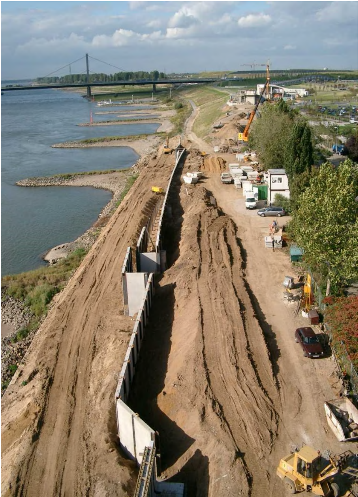
Abb. 73 Arbeiten an der Hochwasserschutzmauer Wiesdorf und an der LAGA-gastronomie (Wacht am Rhein, oben) am 07.10.2004
