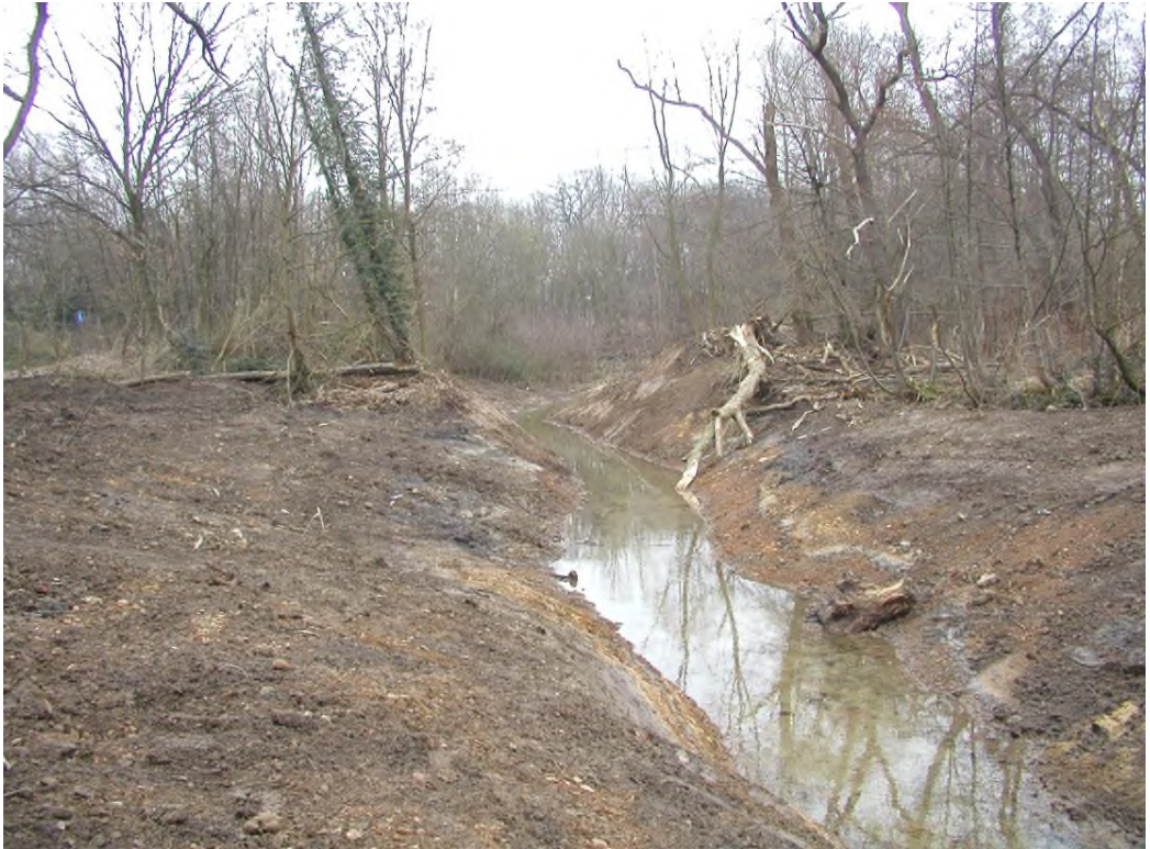
Abb. 70 Im März 2004 wurde vom Wupperverband ein Dhünnseitenarm oberhalb des ehemaligen Auermühlenwehres angelegt. 10.03.2004 Foto: Untere Wasserbehörde
