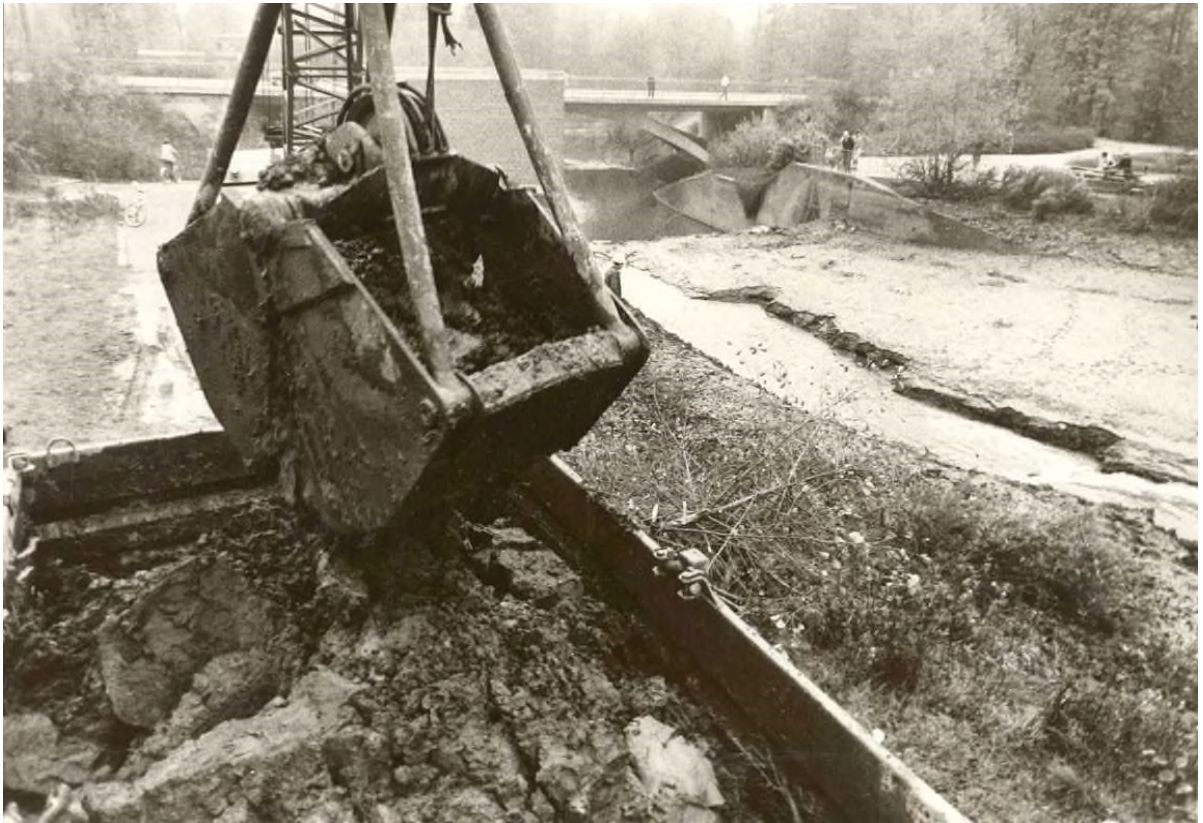
Abb. 43 Bei abgesenkter Wehrklappe musste der sich hier angesammelte Schlamm regelmäßig abgebaggert werden. Oktober 1971
