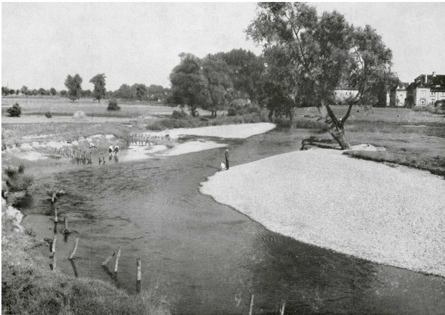
Abb. 67 Dieses Foto der noch unregulierten Dhünn zeigt den Abschnitt zwischen der Kölner Str. und dem Rüttersweg entlang der Johannes-Wislicenus.Str.. Nach dem naturnahen Ausbau haben sich heute an der Dhünn auch wieder Kiesbänke eingestellt.
