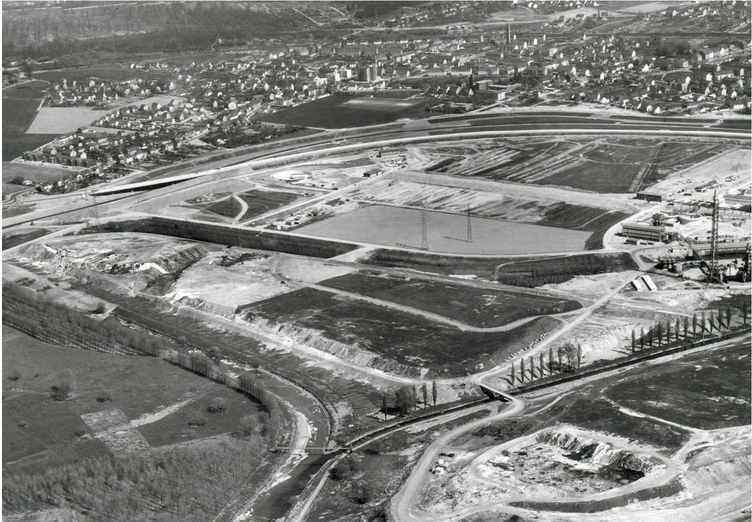
Abb. 24: Diese Luftaufnahme, die etwa 1971 entstand, zeigt im Norden den neuen Dhünnverlauf, der durch den Bau der Deponie Bürrig und den Klärwerksneubau (Mitte am rechten Bildrand) erforderlich wurde. Im unteren Teil des Fotos ist der alte Mündungsbereich der Dhünn in die Wupper (mit der Rohrbrücke der Ruhrgas) zu erkennen. Während der alte Verlauf der Dhünn noch Wasser führt, ist ein Teil des alten Wupperbettes (im linken Bildteil) schon zugeschüttet worden. Durch die Bildmitte verläuft der alte Bürriger Deich. Rechts unten sind auf der „Altlast Dhünnaue“ die Bauarbeiten am Autobahnkreuz Leverkusen-West zu erkennen.
