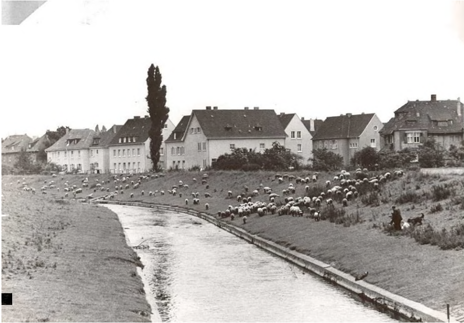
Abb. 68 zeigt die regulierte Dhünn 1954 an gleicher Stelle wie Abb. 34. Am 23.09.2004 hat auch der Wupperverband wieder begonnen den naturnah ausgebauten Bereich mit Schafen zu unterhalten. Außerdem stabilisieren die Schafhufe die Deiche.
