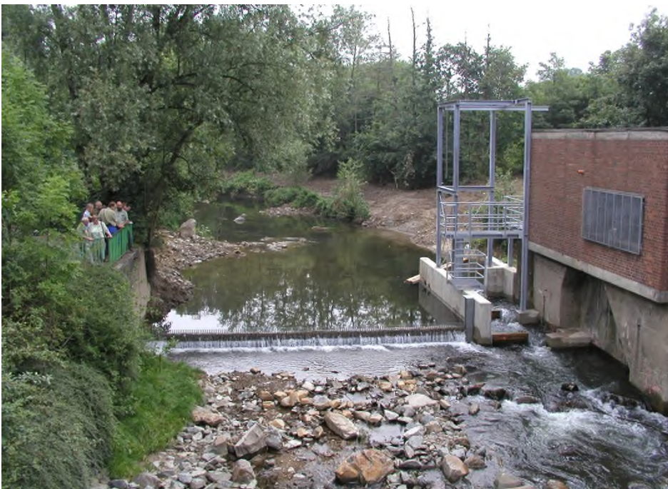
Abb. 55 Die noch ohne Hebevorrichtung und Reuse ausgestattete Fischfang- und Kontrollstation zeigt sich am 07.07.2003. Die links angehobene kleine Wehrklappe soll später nur beim Einsatz der Station aufgerichtet werden. Foto: Untere Wasserbehörde
