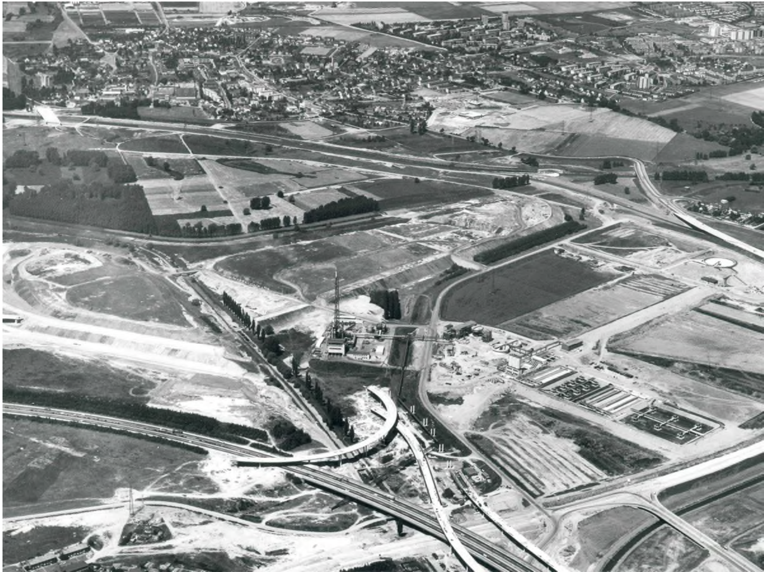
Abb. 25 enthält ebenfalls die Situation der Arbeiten des Klärwerksneubaus, der Wupper- und Dhünnverlegung und des Baus des Autobahnkreuzes Leverkusen-West gegen 1971. In der Bildmitte unten sind schon Teile des Spagettiknotens und am rechten Bildrand ein Vorkläerbecken des Wupperverbandes zu erkennen. Vorhanden ist im Norden über dem neuen Flussbett der Wupper schon die Autobahnbrücke der A 59. Foto: Stadtarchiv Leverkusen
