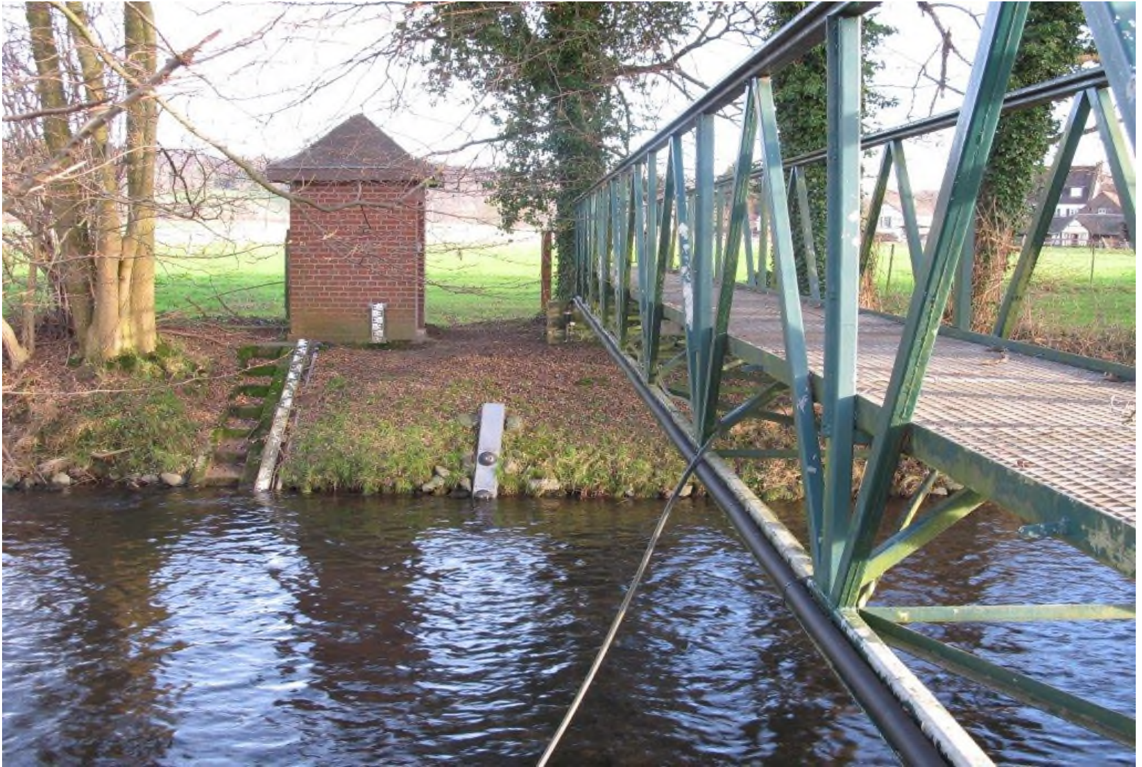
Abb. 50 In Leverkusen–Hummelsheim betreibt der Wupperverband zur Abflusskontrolle der Großen Dhünntalsperre einen eigenen Pegel. 28.12.15
