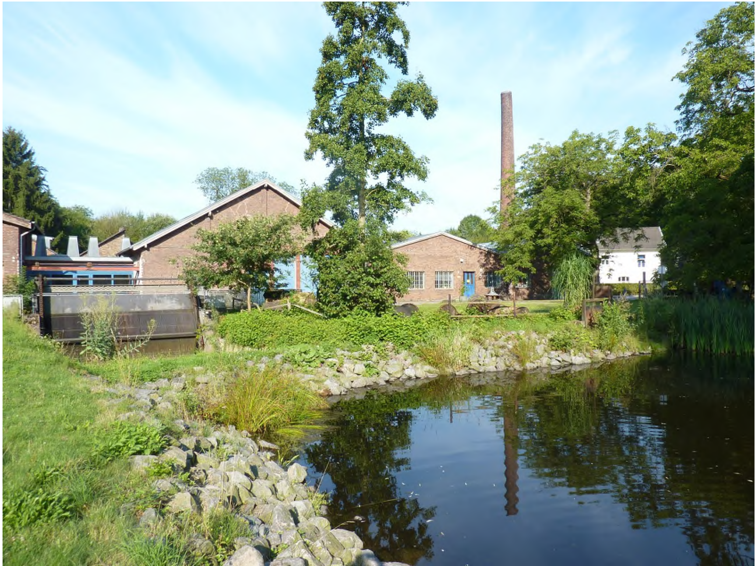
Abb. 33 Der Zulauf aus dem Stauteich des Freudenthaler Sensenhammers zur Turbine wurde durch einen Damm verschlossen. Dahinter ist der Rechen zu erkennen. 27.07.2014
