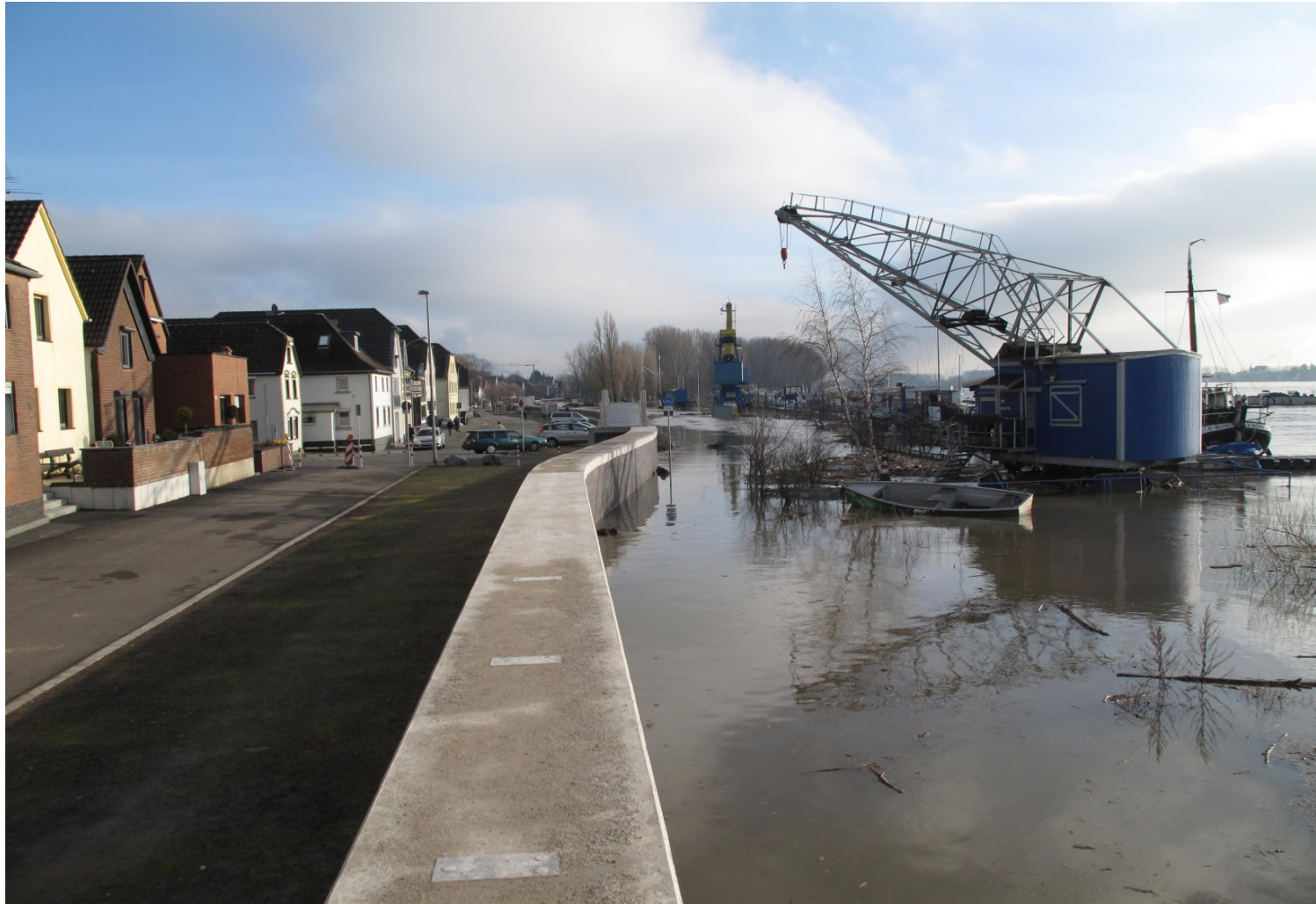
Abb. 79 Der überschwemmte Hitdorfer Hafen zeigt sich am 08.01.2011 bei Rheinhochwasser. In die abgedeckten Köcher in der festen Hochwasserschutzmauer kommen bei Bedarf Elemente des mobilen Teils der Hochwasserschutzmauer.
