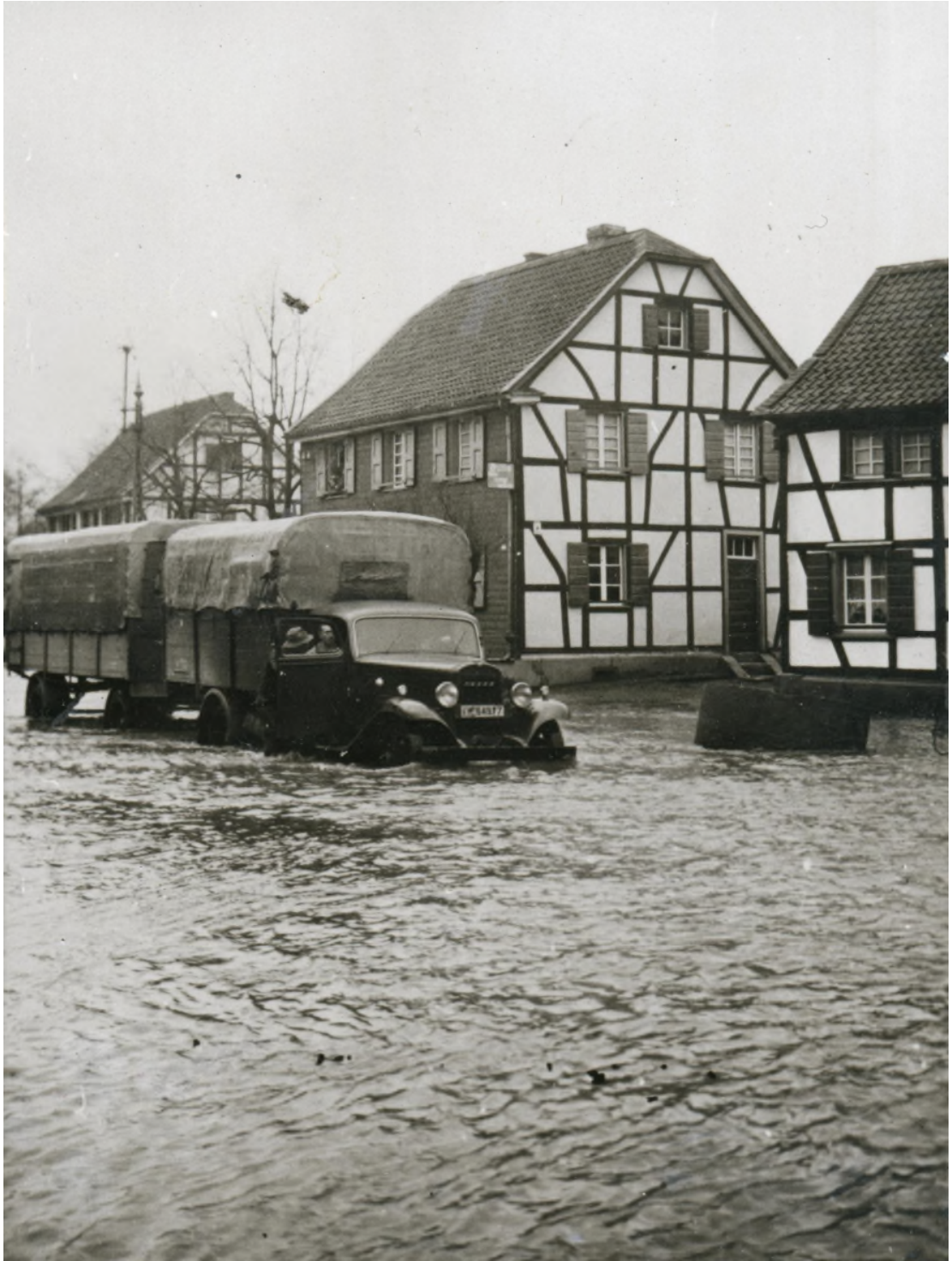
Abb. 8: Hauptstr. in Schlebusch bei dem Dhünnhochwasser 1924
