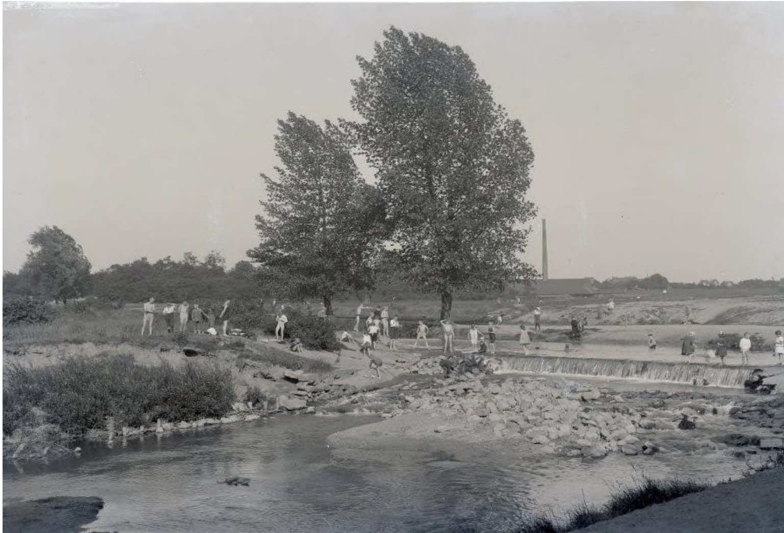
Abb. 44a Das Bild ist mit „Wasserfall an der Dhünn“ beschriftet. Zu sehen ist die Wasserentnahme aus der noch nicht regulierten Dhünn in den Zuleitungsgraben zur Doktorsburg und zur Küppersteger Mühle (siehe auch Abb. 46). Der Schornstein in der rechten Bildhälfte gehört zur Wiesdorfer Ringofenziegelei im Bereich der heutigen Straßen Moltkestr./Am Vogelsfeldchen. Vor 1927 Foto: Stadtarchiv Leverkusen
