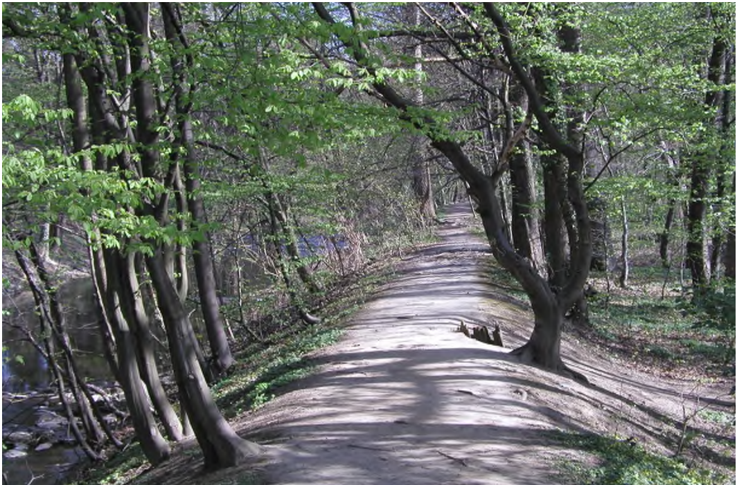
Abb. 5: Durch den massiven Deichbewuchs ist der Hochwasserschutz in Schlebusch eingeschränkt. 17.04.2003
