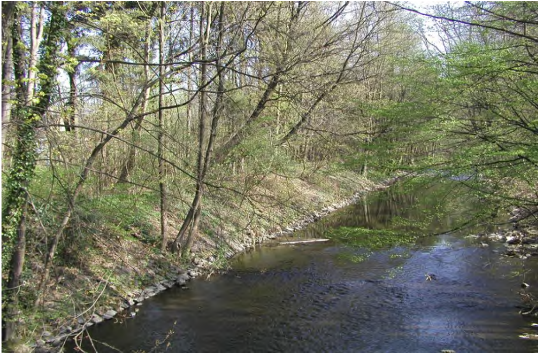
Abb. 4: Die Dhünn ist in Schlebusch entlang der Deiche mit einem Wasserbausteinpflaster befestigt. 17.04.2003
