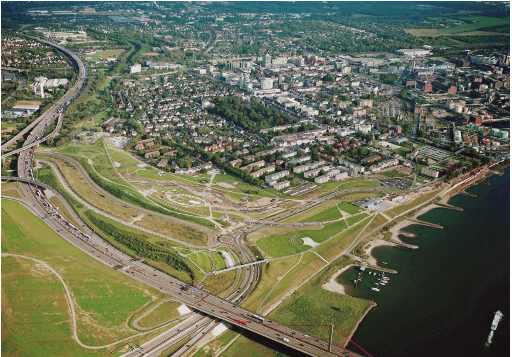
Abb. 74 Rechts am Bildrand ist der Bau des Wiederfer-Hochwasserschutzes zu erkennen. Das Gelände zwischen der Bebauung und der A 1 für die Landesgartenschau 2005 ist noch nicht abschließend fertiggestellt. Das Gelände der LAGA und die Fläche südwestlich der A 1 ist die gesicherte Deponie „Altablagerung Dhünnaue-Mitte“. Wird die A 1 wie vorgesehen oberirdisch verbreitert, ist ein Eingriff in den Deponiekörper und damit auch eine Beschädigung des Dichtungssystem unumgänglich. August 2004
