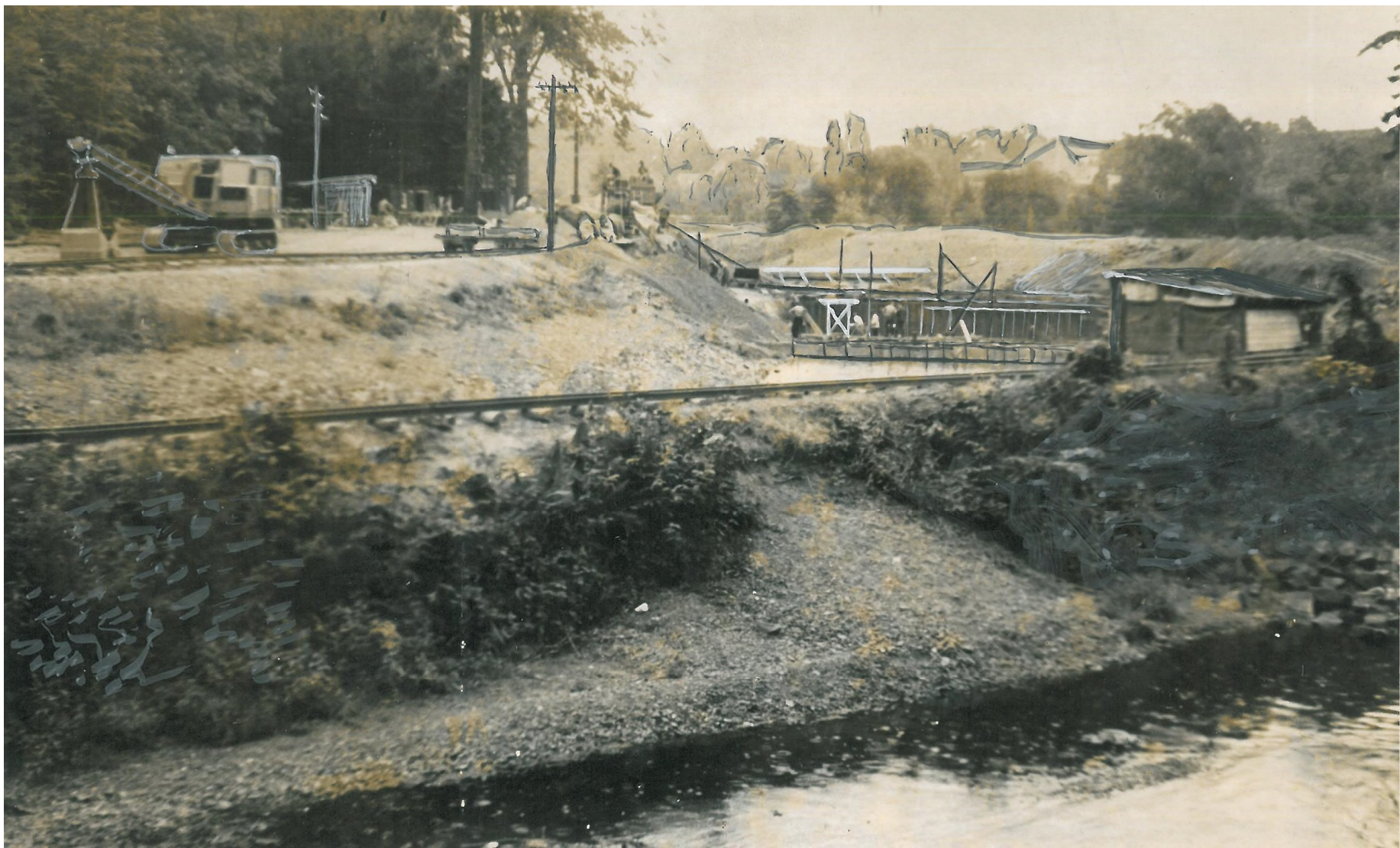
Abb. 42 Bau des neuen Aermühlenwehres um 1953 Die Dhünn wird an der Baustelle in Fließrichtung links vorbeigeführt
