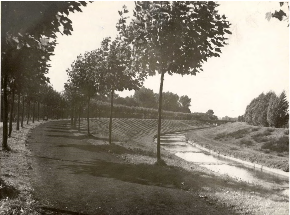
Abb. 18 zeigt die regulierte und eingedeichte Dhünn am Stadtpark. Hinten ist die Brücke der Köln-Mindener Eisenbahn zu erkennen.
