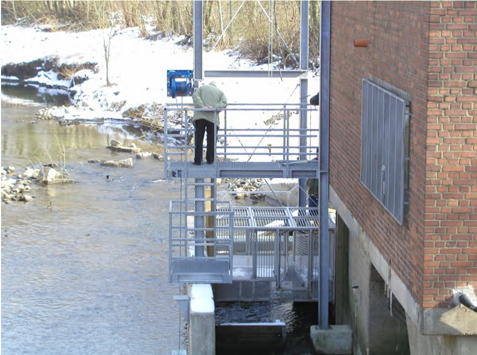
Abb. 54 Am 01.03.2004 wird die Reuse in der neu angelegten Fischfang- und Kontrollstation am ehemaligen Auermühlenwehr mit der dort vorhandenen Hebeeinrichtung probeweise an ihren Platz herabgelassen. Foto: Untere Wasserbehörde
