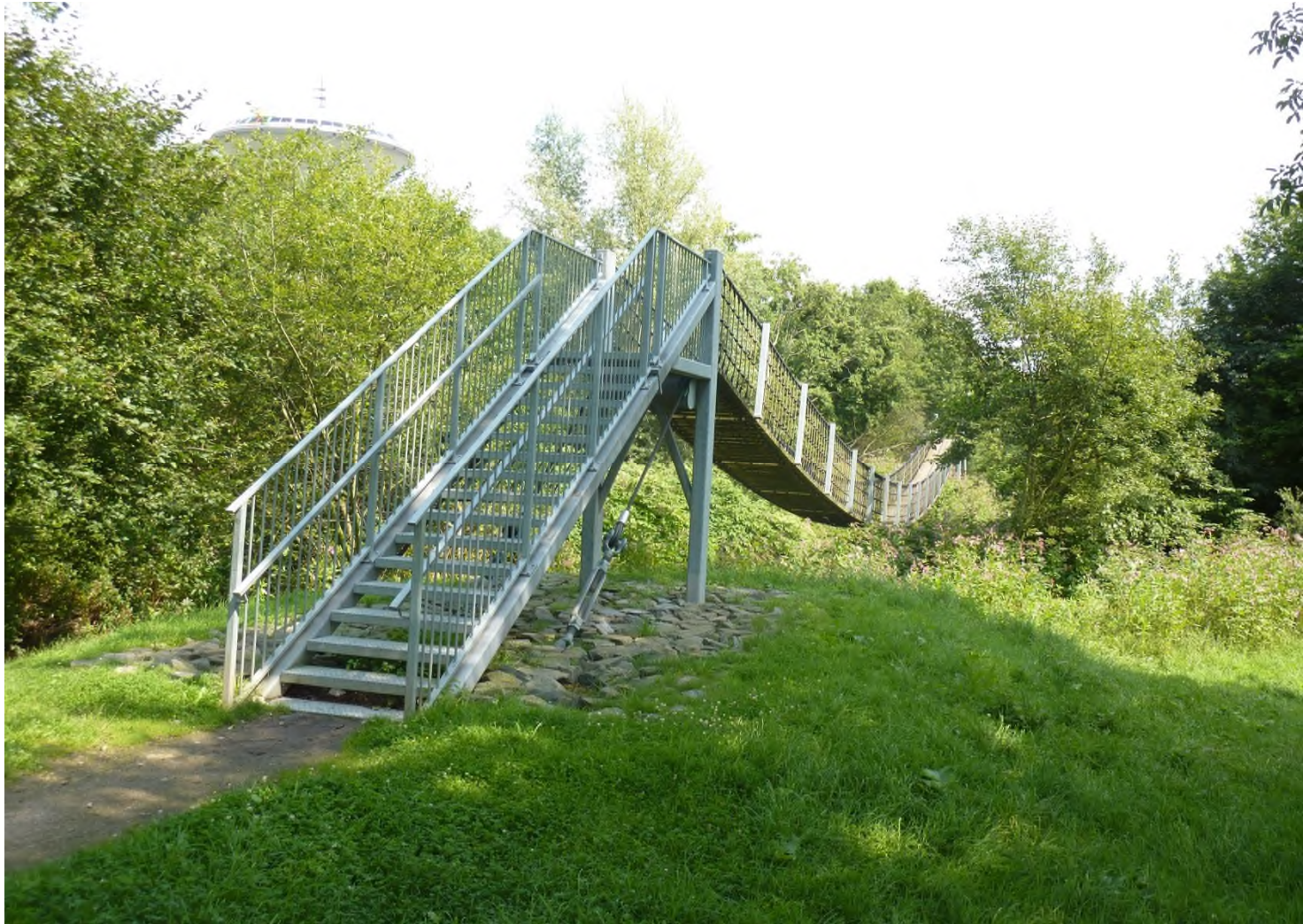
Abb. 62 Die Wackelbrücke südlich der A 1 in der Nähe des Wasserturms der EVL wurde für die Landesgartenschau 2005 errichtet. Die als temporärer Übergang vorgesehene Brücke wurde auf Wunsch der Politik nach der Gartenschau nicht zurückgebaut. Bild vom 05.08.2014
