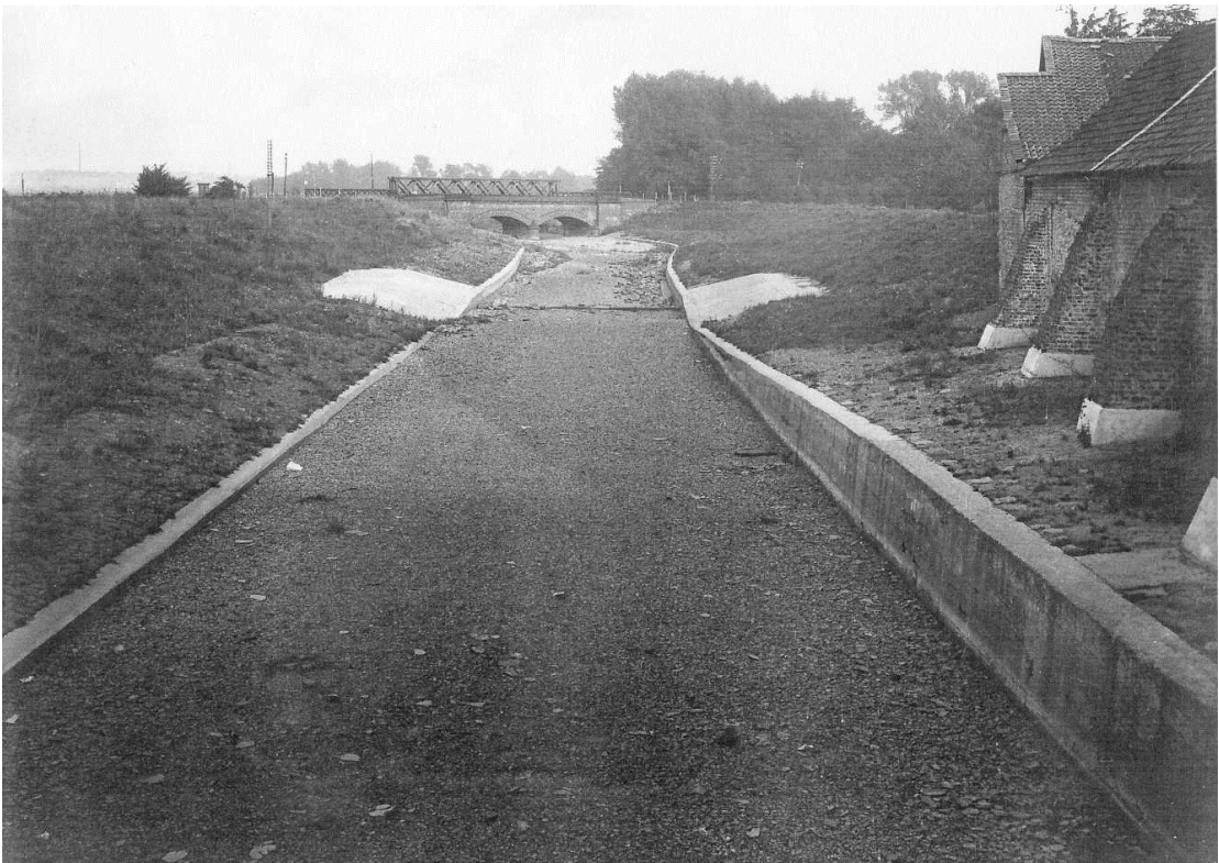
Abb. 64 zeigt die regulierte Dhünn noch ohne Wasser zwischen der Kölner Str. und der Köln-Mindener Eisenbahn. Die im Deich liegende Scheune des Breidenbacher Hofes nimmt damit ebenfalls Hochwasserschutzaufgaben wahr.
