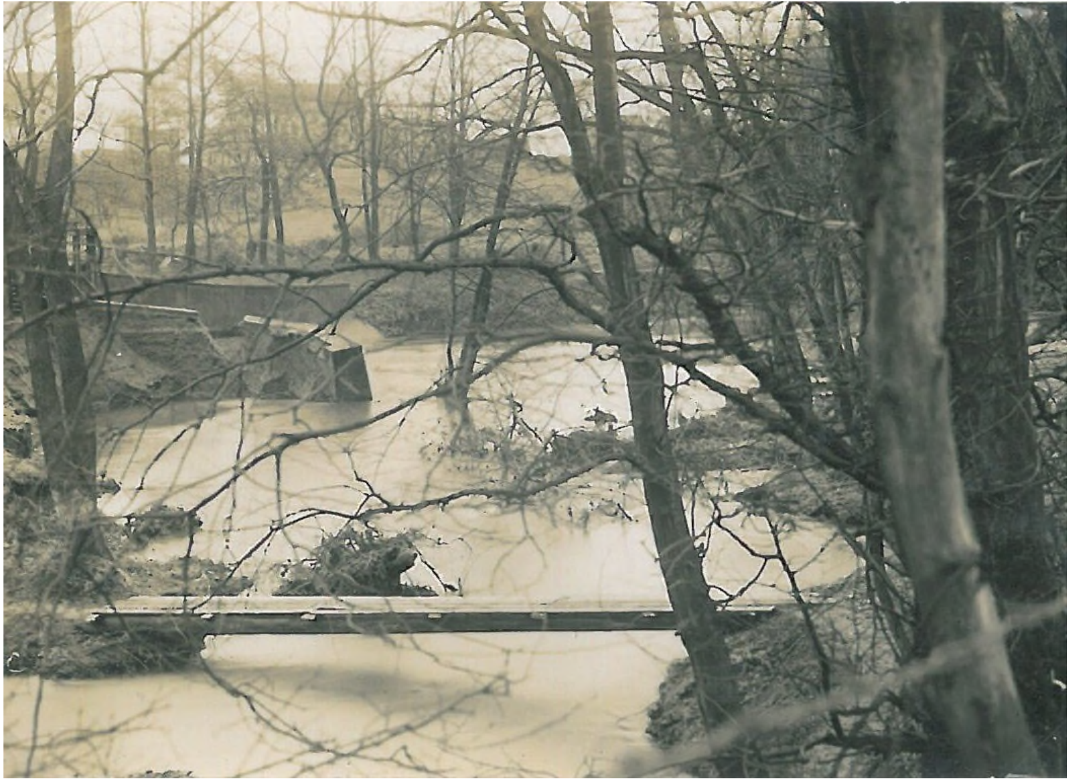
Abb. 39 Bei Hochwasser floss die Dhünn teilweise rechts am Aermühlen Wehr vorbei.
