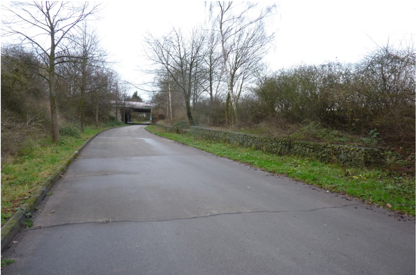
Abb. 76 Zwischen der BAB A 59 und dem Wasserwerk Hitdorf der Currenta GmbH & Co. OHG liegt entlang der Unterstraße eine Hochwasserschutzanlage des Deichverbandes Leverkusen. Der Deichfuss ist mit einer Gabionenwand gesichert. 05.01.2016 Foto: Untere Wasserbehörde
