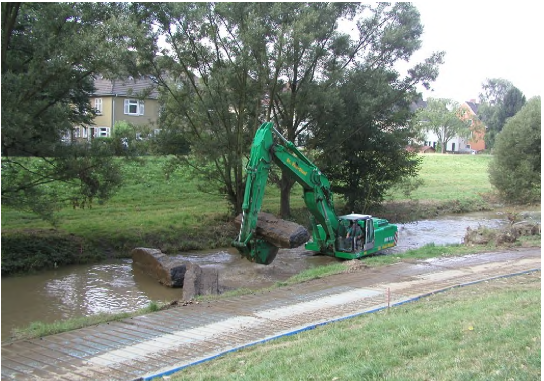
Abb. 57 Zwei Tage später ist der Baggerführer mit seinem Gerät etwas unterhalb bei der Arbeit. Ein Teilstück der Betoneinfassung wird während der Landesgartenschau 2005 in diesem Bereich außerhalb der Dhünn zu sehen sein. Foto: Untere Wasserbehörde
