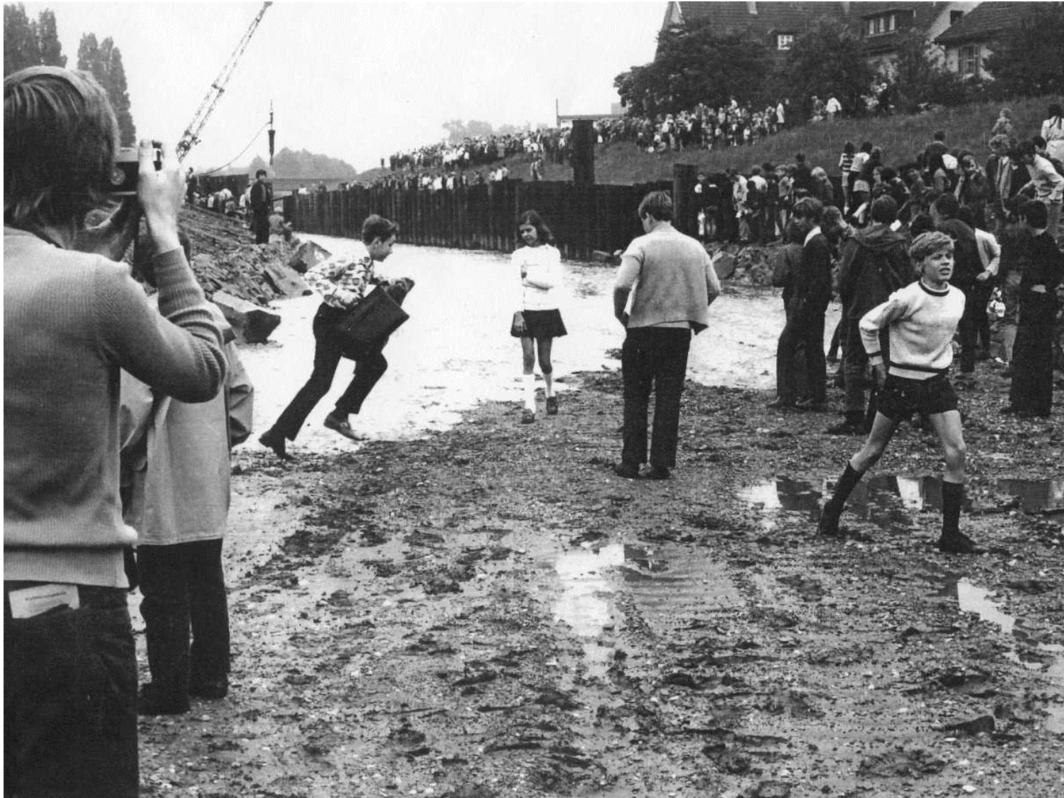
Abb. 23: Am 26.05.1971 wird das neue Dhünnbett zwischen Wiesdorf und Bürrig geflutet.
