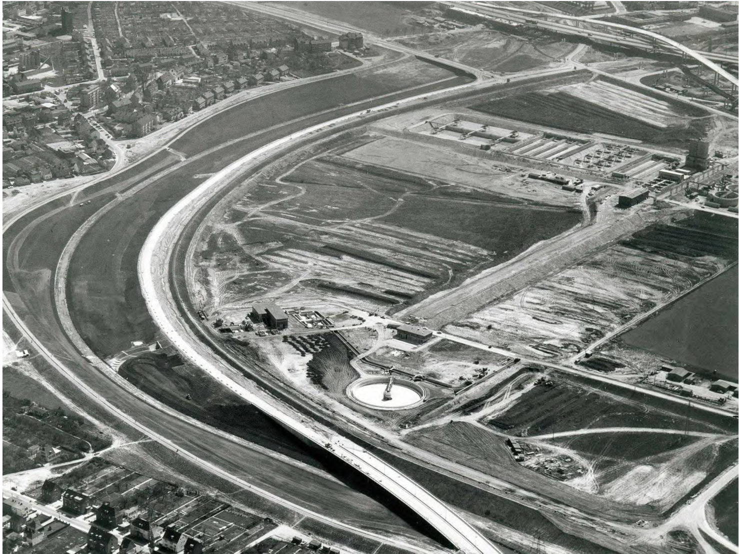
Abb. 27 : Neben den Arbeiten auf dem Klärwerksgelände ist zwischen den Brücken Olof-Palme-Str. und Westring das noch wasserlose neue Flussbett der Dhünn zu erkennen. In Fließrichtung links der Dhünn befindet sich im linken Bildteil der Notüberlauf aus dem Klärwerksteil des Wupperverbandes in die Dhünn.
