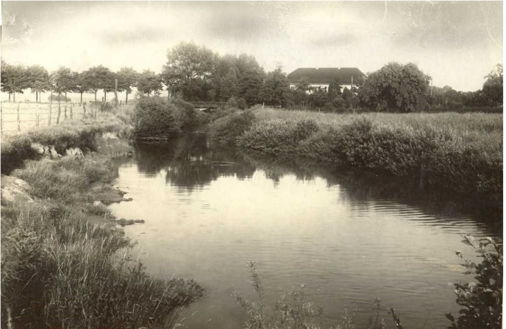
Abb. 63 Dieses Bild gibt einen Blick über die noch nicht regulierte Dhünn auf die Brücke Kölner Str. und den Breidenbacher Hof.
