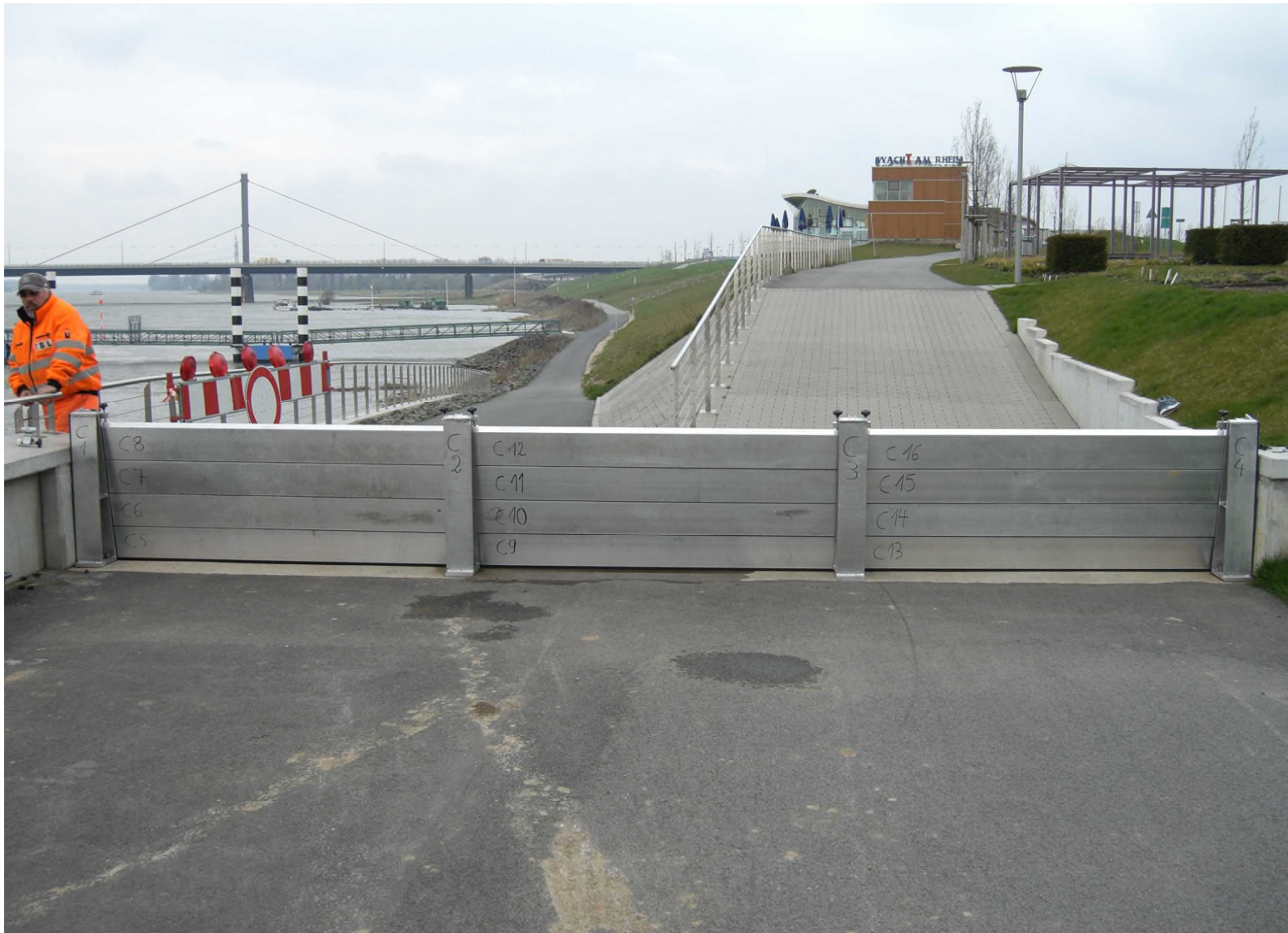
Abb. 75 Testaufbau der Hochwasserschutztoore im Wiesdorfer Hochwasserschutz im April 2006
