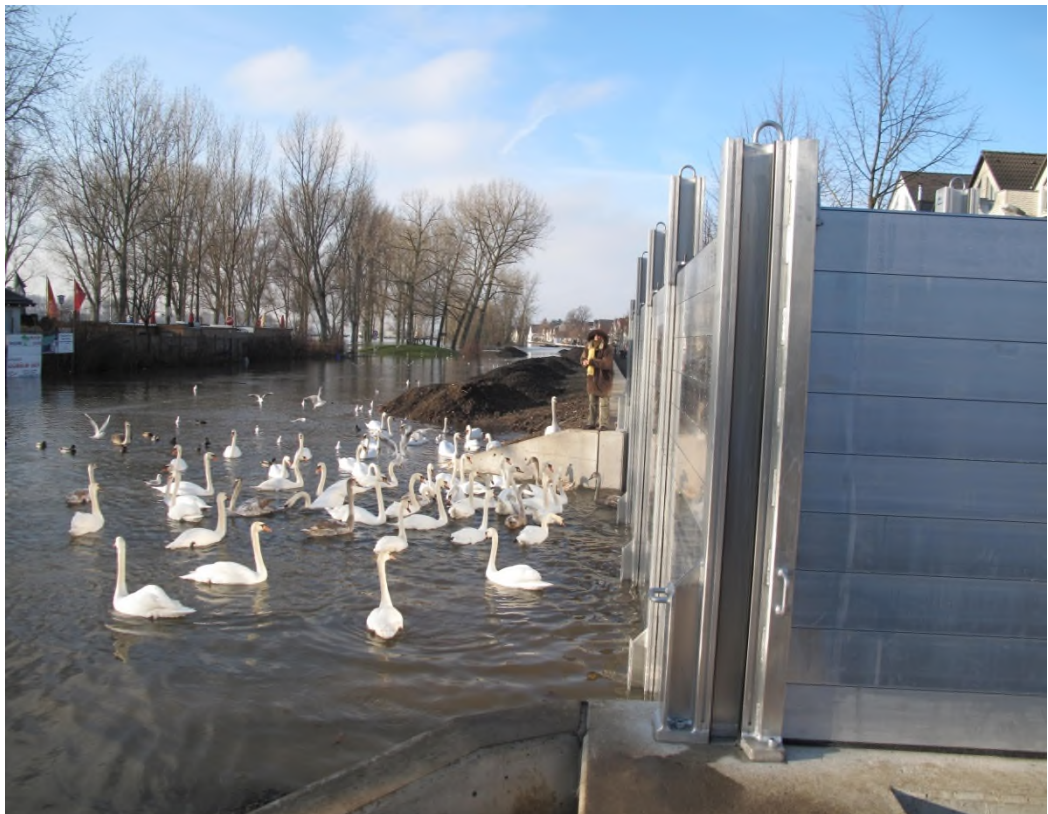
Abb. 78: Aufgebautes Hochwasserschutztor „Fährstr.“ der Hochwasserschutzwand Hitdorf 08.01.2011
