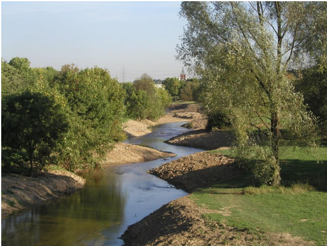
Abb. 58 Blick von der Brücke Olof-Palme-Str. über die naturnah ausgebaute Dhünn auf die St. Stephanus-Kirche von Bürrig am 26.09.2003
