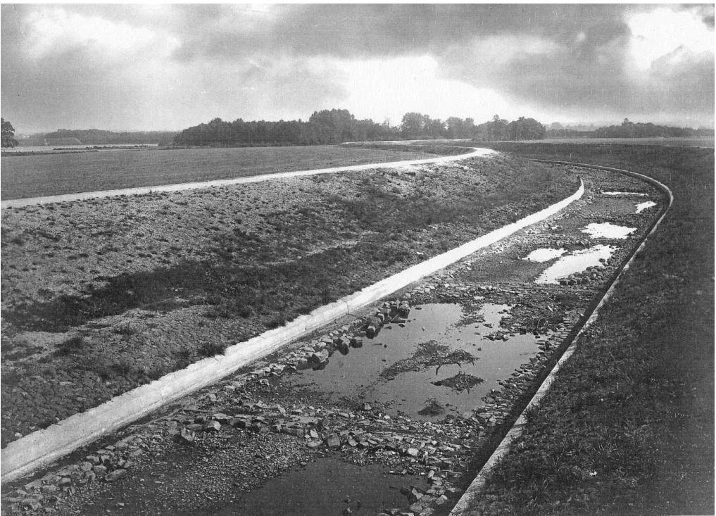
Abb. 16 Die Dhünn ist Ende der 1920er Jahre technisch ausgebaut. Deutlich sind die Sohlschwellen, die uferbegleitenden Betoneinfassungen und die Sohlen- und Bermenpflasterung zu erkennen. 1926 - 1927
