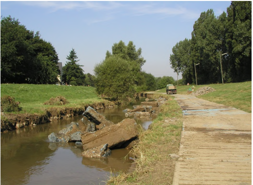
Abb. 56 Am 29.07.03 liegen in der Dhünn unterhalb der Brücke Europaring die mit einem Bagger abgebrochenen Teile der Betoneinfassung zum Abtransport bereit. Foto: Untere Wasserbehörde
