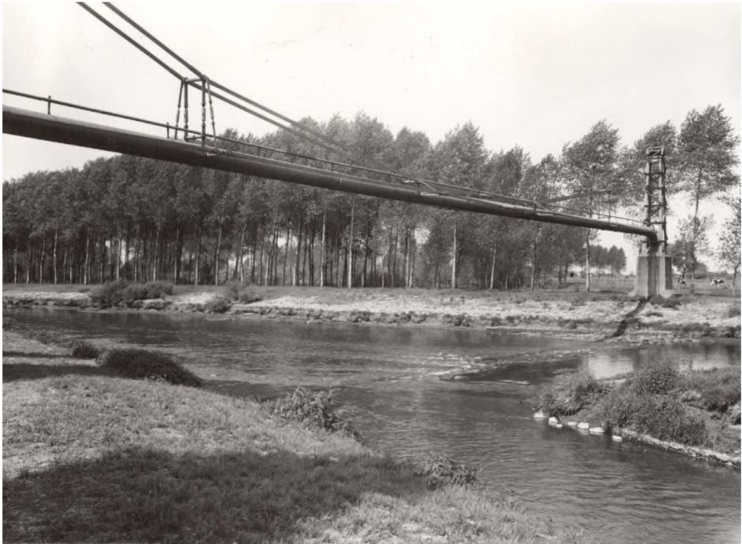
Abb. 21: Im Mündungsbereich des alten Dhünnverlaufs in die Wupper befand sich eine Rohrbrücke der Ruhrgas AG (siehe auch Abb. 24). Im Rahmen des Baus der Deponie Bürrieg wurde diese Gasleitung ins Rheinvorland verlegt.
