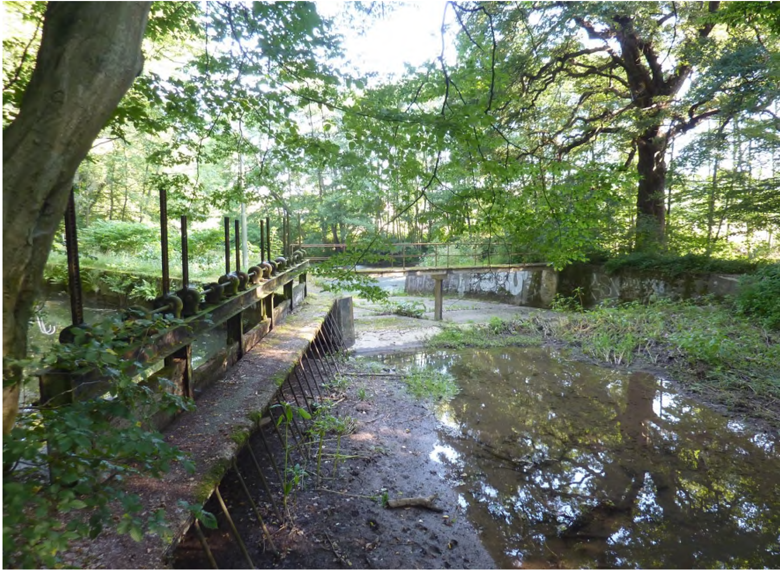
Abb. 32 : Das Freudenthaler Wehr ist mit seinen Nebenanlagen erhalten. Hier sieht man die Brücke über das Wehr. Vor dem Zulauf zum Mühlengraben haben sich schon größere Ablagerungen gebildet. 27.07.2014
