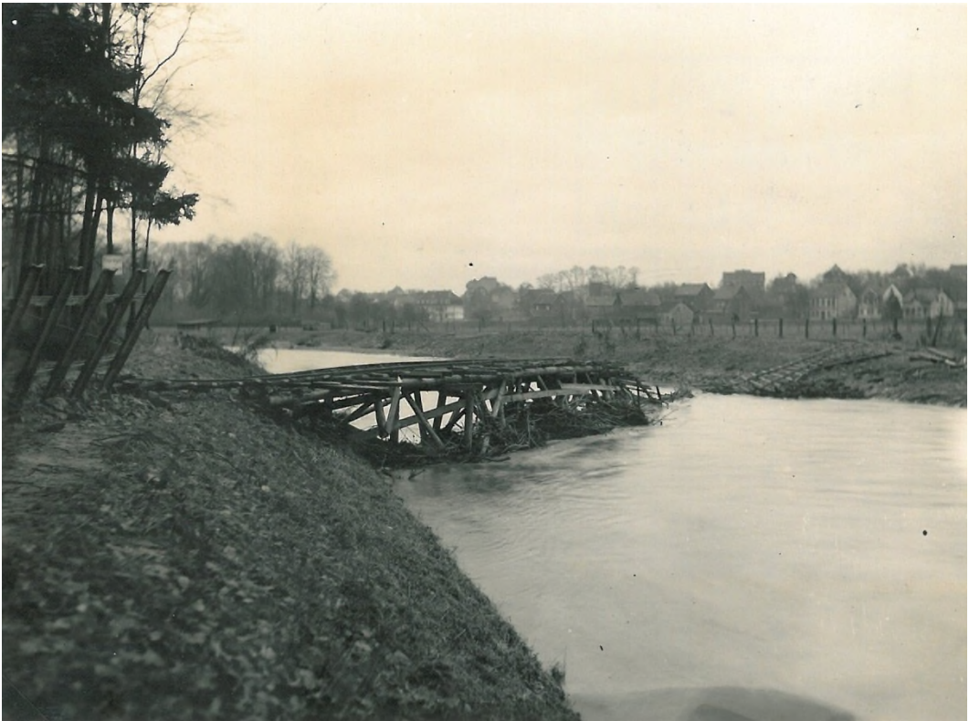
Abb. 11: Vom 03. auf den 04.01.1932 schob sich eine Hochwasserwelle durch Schlebusch, die eine Feldbahnbrücke zerstörte. 06.01.1932
